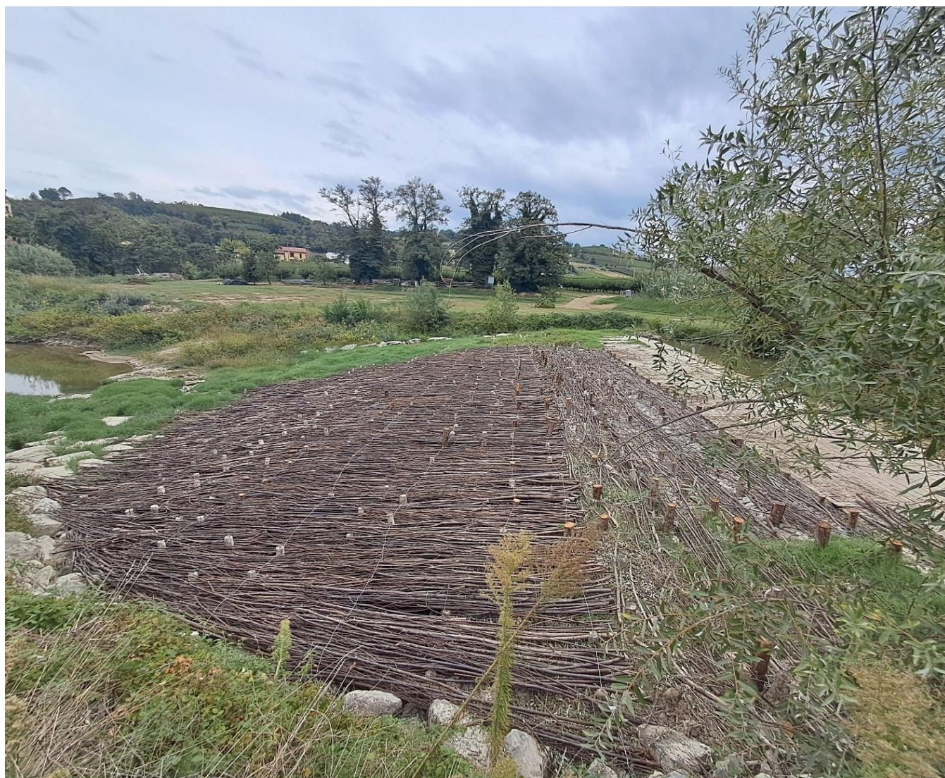
La Diga Steccaia a Tebano (foto di Mario Cavina).
